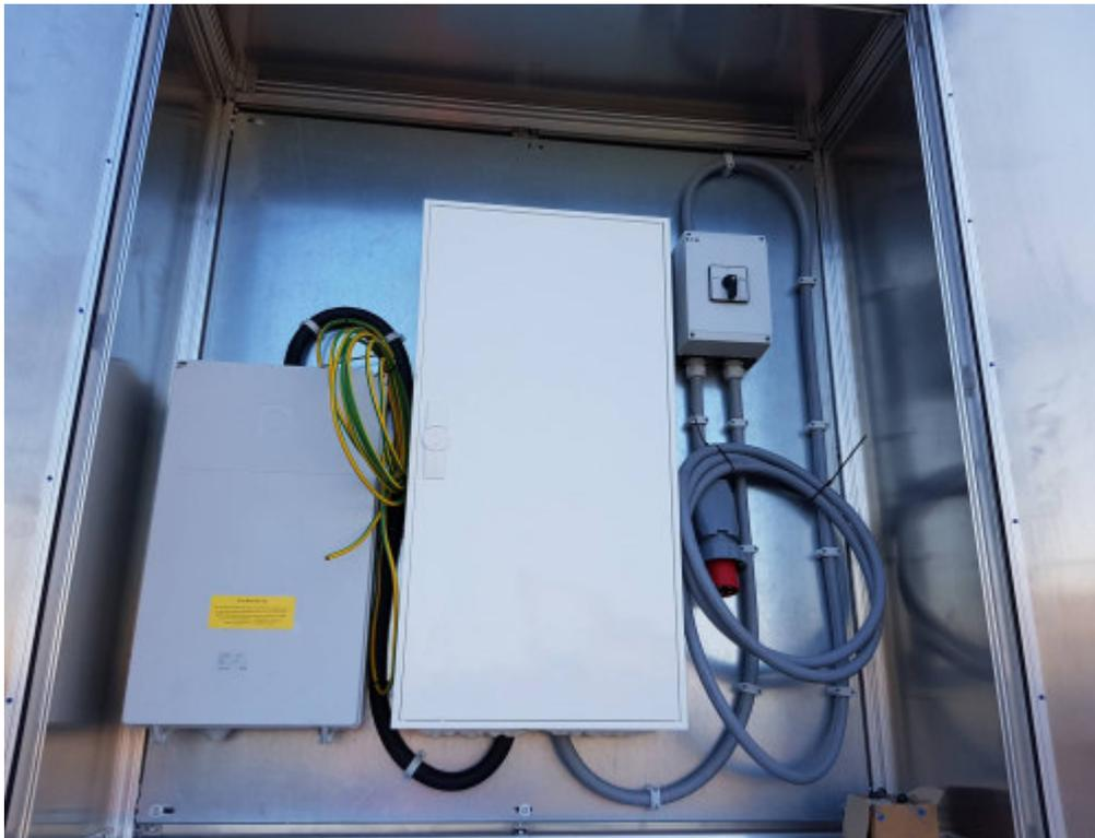
Abbildung: Freiluftschrank (Jacob) mit Wandlermessung.
