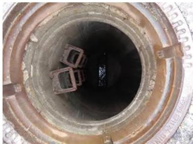
3,64 m DCM C      Schmutzfänger unter der Abdeckung, Schmutzfänger schadhaft      3
