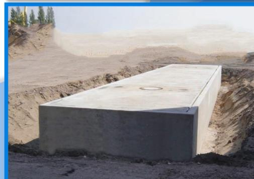
**Bitte beachten: bei Brückengröße 20 x 3 m ist das Fertigteilfundament zweiteilig (in der Mitte quergeteilt)!**
